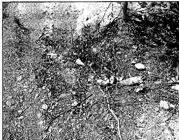
Sumidero lateral colmatado de sedimentos y vegetación
